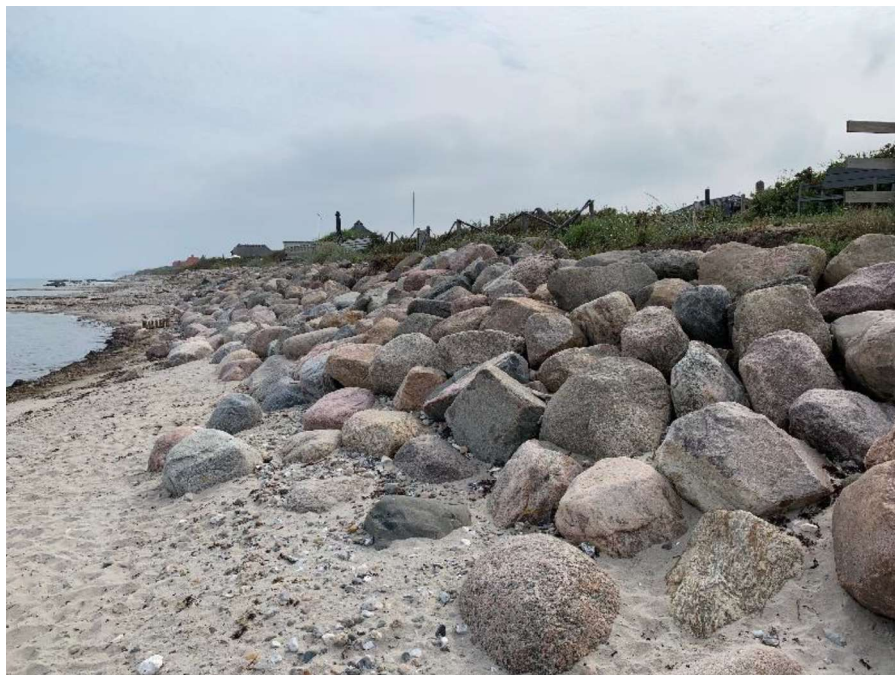
Figur 2.3: Skråningsbeskyttelse på delstrækning A og A+ set mod øst
